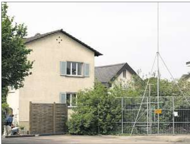
Die neue Mobilfunkantenne soll mitten im Wohnquartier Hanfländer aufgestellt werden. (Nadine Ackermann)
