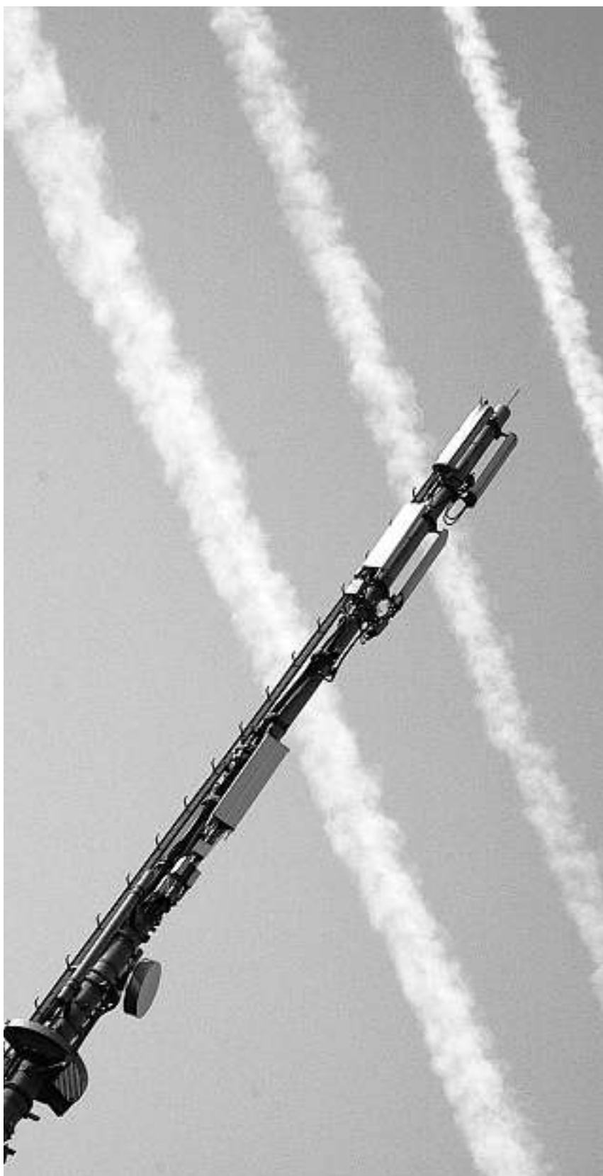
Notwendiges Übel: Die Mobilfunkantenne im Gelände der ehemaligen Herbag ist eine von zweien in Schmerikon. Bild Silvan Stricker
