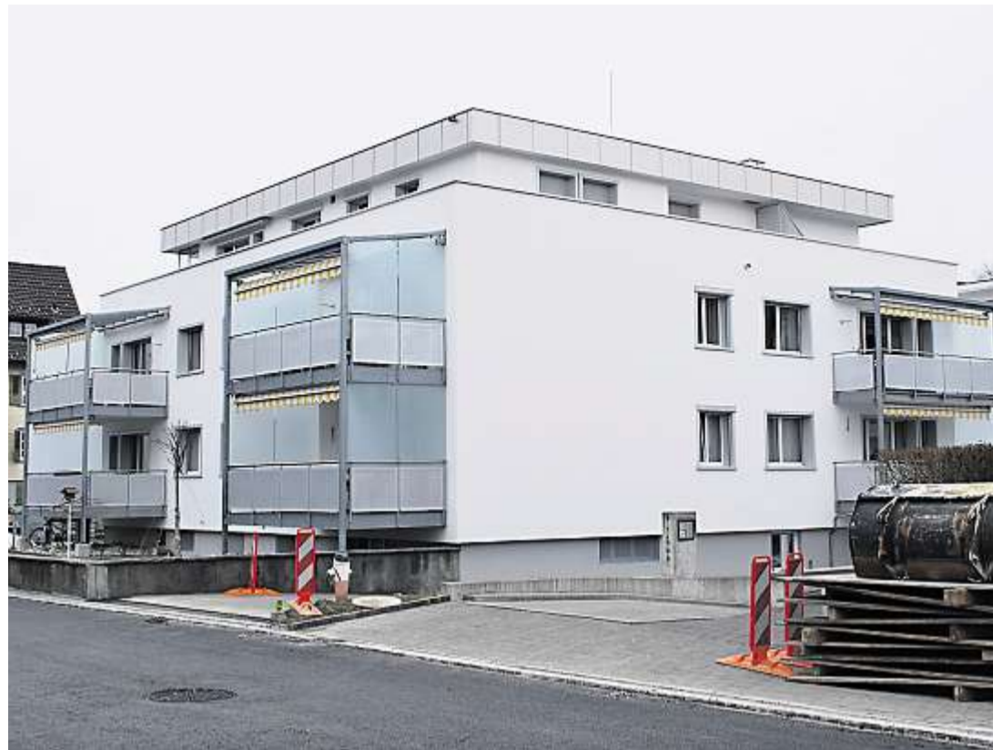
Etwas mehr als drei Jahre dauerte das Verfahren an der Attenhoferstrasse 2. Bild: Marco Lügstenmann
