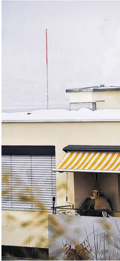
Störende Strahlen: Die Anwohner der Belsitostrasse 30 stören sich an der geplanten Sunrise-Handyantenne – drei weitere Antennen sind geplant.
