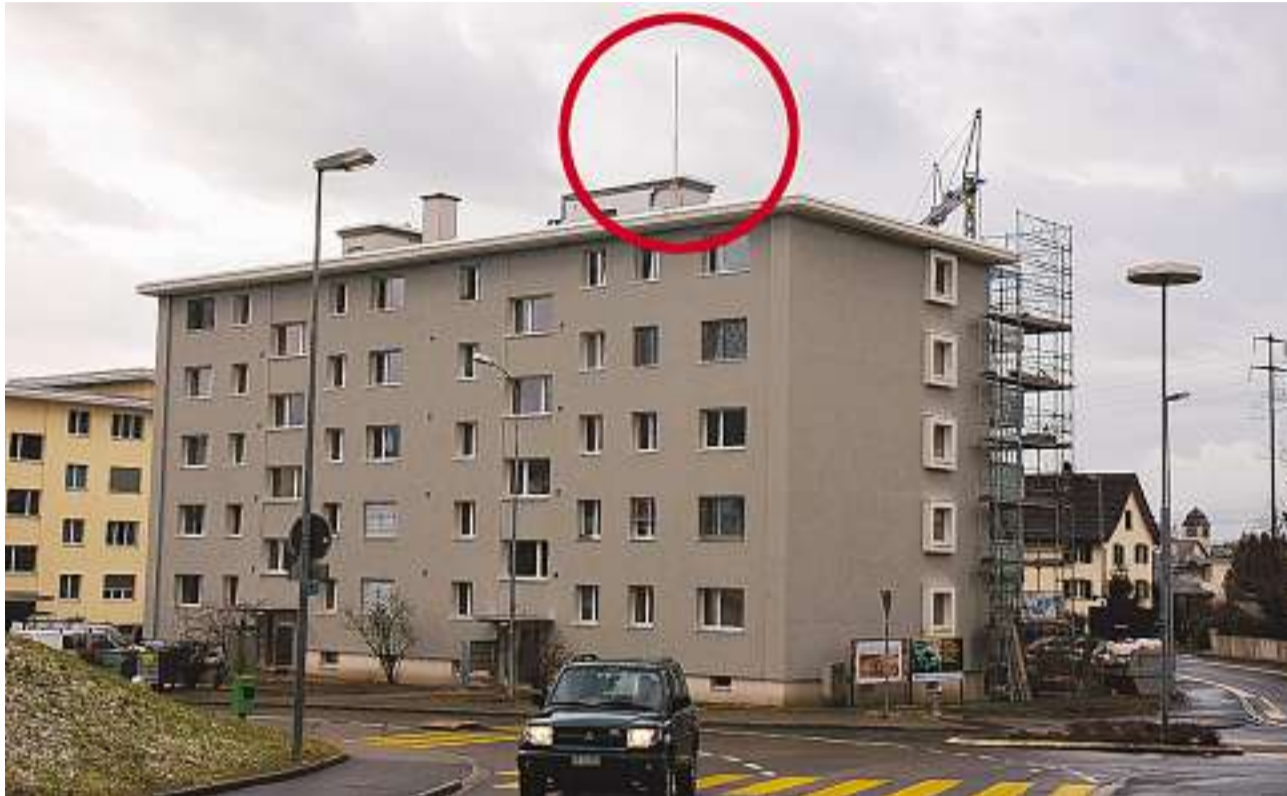
Verschandelung des Ortsbilds? Die Antenne an der Joner Aubrigstrasse soll sechs Meter hoch werden. Bild Adrian Huber
